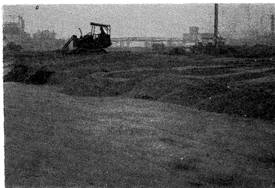
第11図 白泥地盤のファゴット・シート工法。
